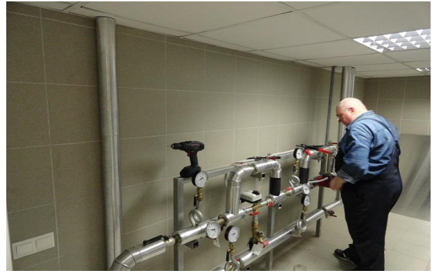
Изоляция и ожеуживание узлов теплоснабжения вентустановок
