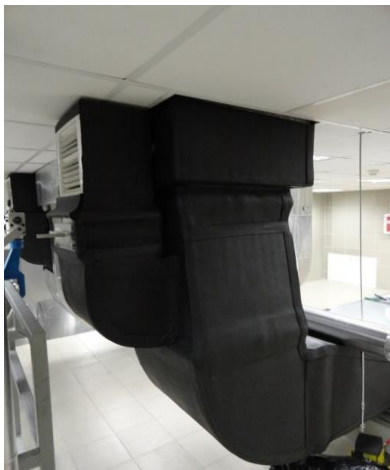
Теплоизоляция воздуховодов, имеющих тройное смещение в разных плоскостях
