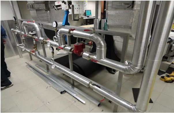
Изоляция и ожеуживание узлов теплоснабжения вентустановок
