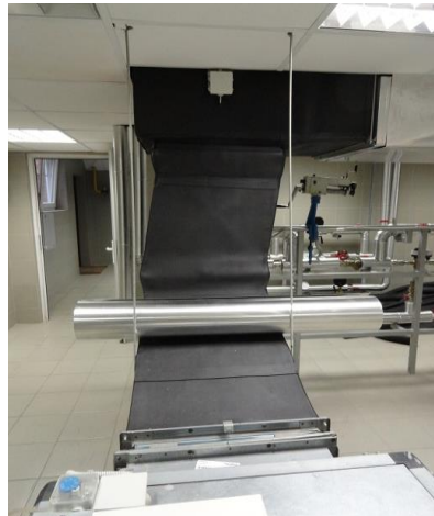
Теплоизоляция воздуховодов, имеющих тройное смещение в разных плоскостях
