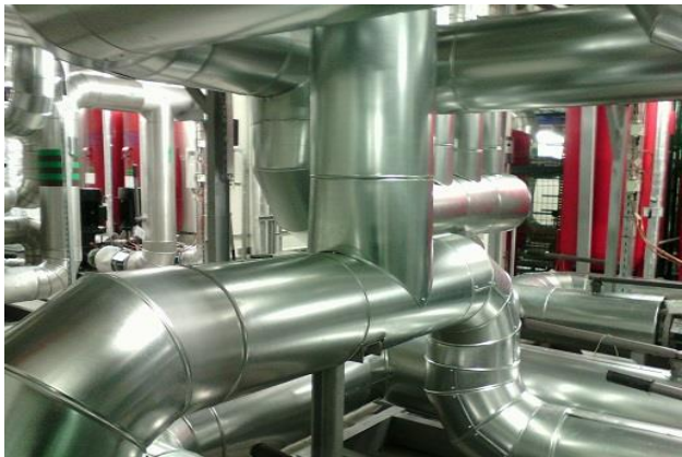
Пример выполненных работ по озооушиванию труб в ЦТП Башня Эволюция на Москва - Сити. Заказчик: ООО «Р.Д. Менеджмент сервисз»
