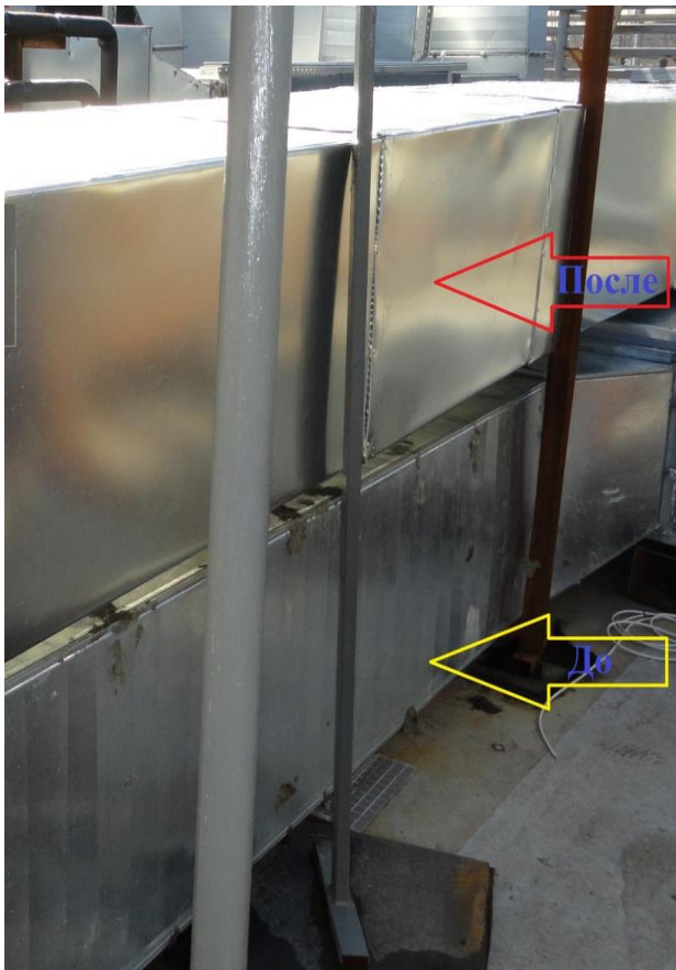
Монтаж стальных оцинкованных кожухов на воздуховодах, расположенных на кровле объекта Торгово-технический центр по продаже, обслуживанию и ремонту автомобилей Мерседес ДЦ «Звезда Столицы Каширка»
