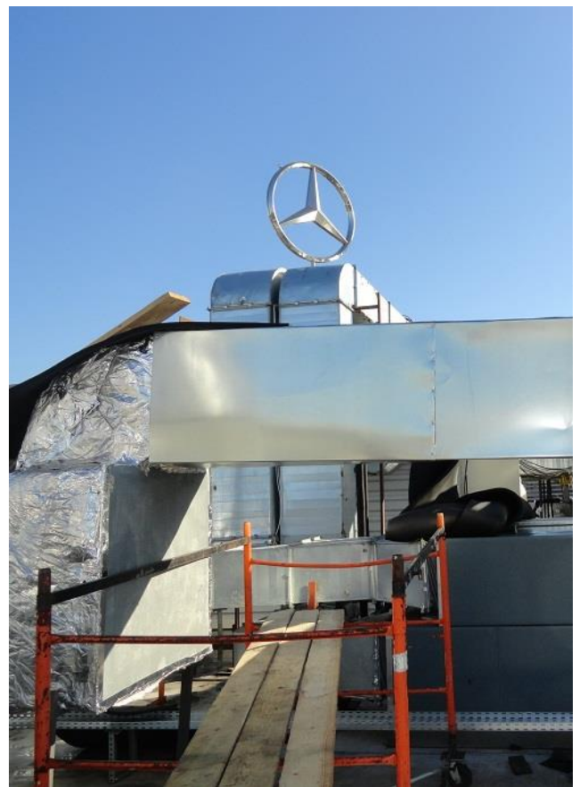
Монтаж стальных оцинкованных кожухов на воздуховодах, расположенных на кровле объекта Торгово-технический центр по продаже, обслуживанию и ремонту автомобилей Мерседес ДЦ «Звезда Столицы Каширка»
