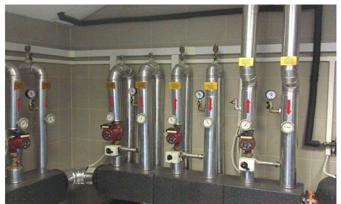
Теплоизоляция и ожеуживание распределительных гребенок системы отопления
