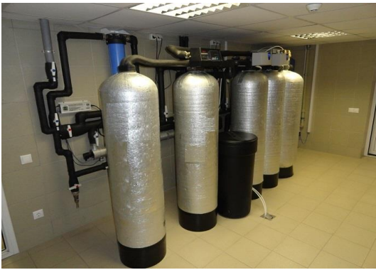
Изоляция труб системы водоочистки
