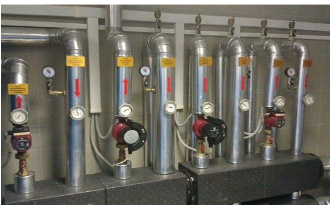
Теплоизоляция и ожеуживание распределительных гребенок системы отопления
