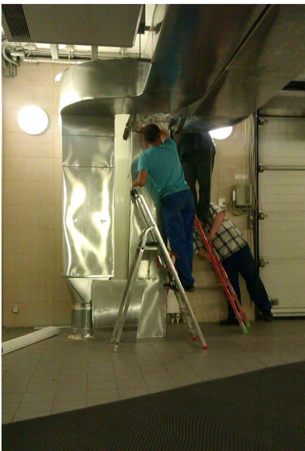
Монтаж алюминиевых кожухов на воздуховодах, расположенных в VIP гараже компании Роснефть, офисное здание на ул. Дубининская
