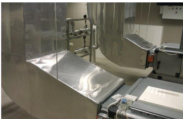
Окожушивание прямых воздуховодов, отводов и переходов
