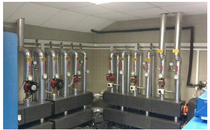
После выполнения работ
