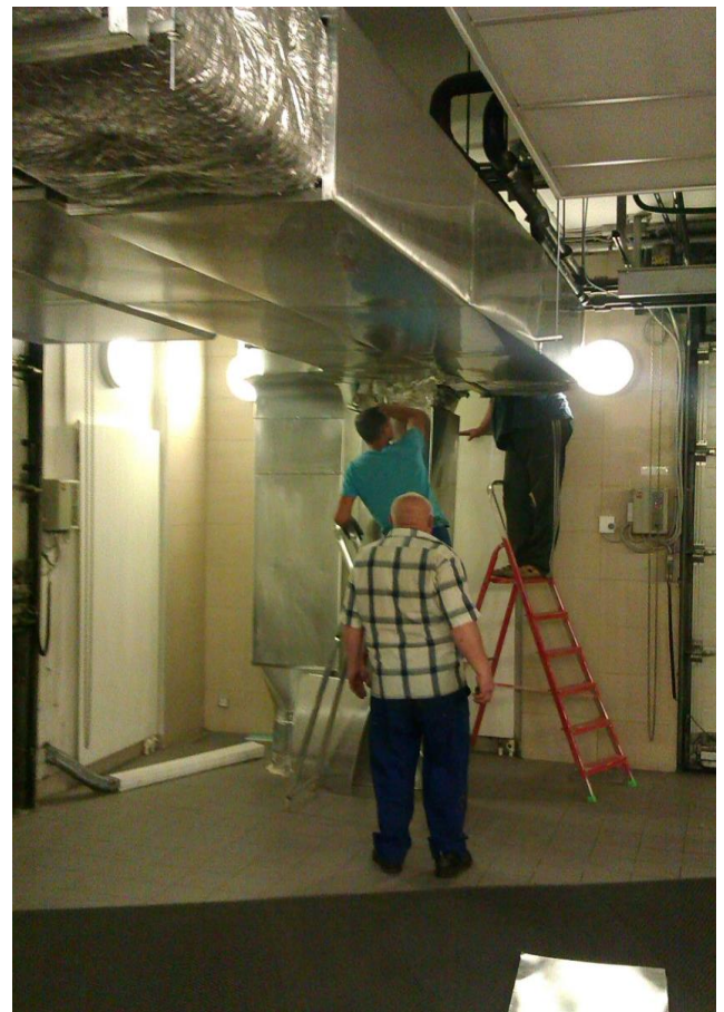
Монтаж алюминиевых кожухов на воздуховодах, расположенных в VIP гараже компании Роснефть, офисное здание на ул. Дубининская
