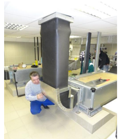
Теплоизоляция воздуховодов, имеющих тройное смещение в разных плоскостях
