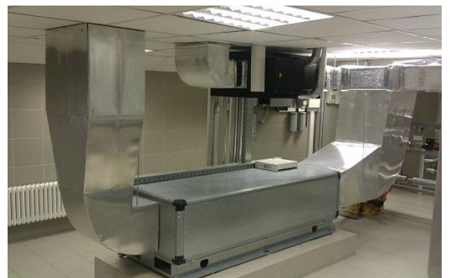
Окожушивание прямых воздуховодов, отводов и переходов
